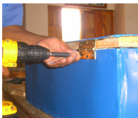
b. Fijar las bisagras con tornillos de 1 ½".
