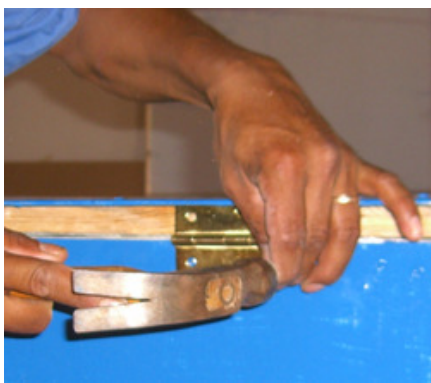
a. Usar un clavo para perforar el zinc antes del tornillo.
